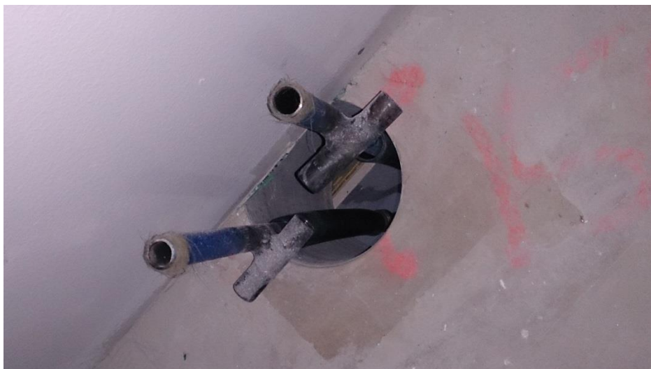
Figur 18 Öppna röravslut börr sättas igen så att luft inte transporteras bort genom röret. (Egen bild)
