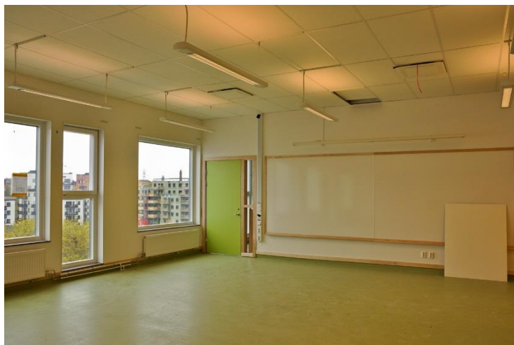
Figur 11 Ett typrum i det närmsta färdigställt (täthetsprov utfördes tidigare i produktionen). (Egen bild)
