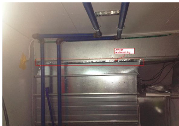
Figur 23 Läckage i en ventilationskanal. (C. Gustafsson, Energikompentens, 2013)
